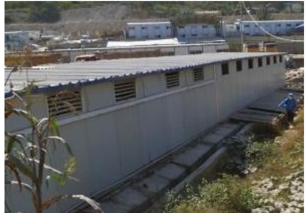
施工营地实施消杀灭虫
