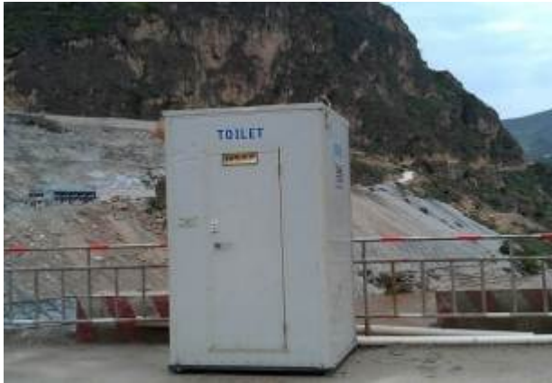
施工临时移动厕所
