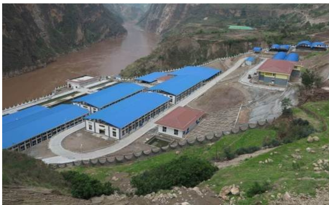
金沙江乌东德白鹤滩水电站珍稀特有鱼类增殖放流站
