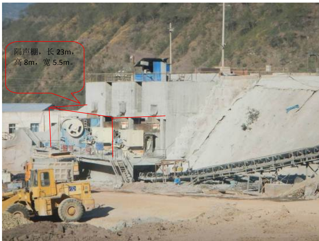
图 6.7-9 粗碎车间隔声防护棚示意图
