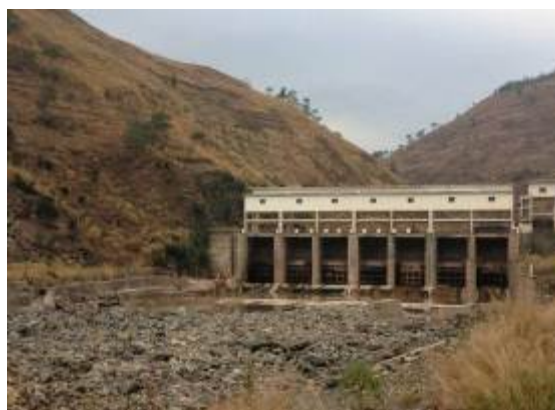
公德房电站闸坝
