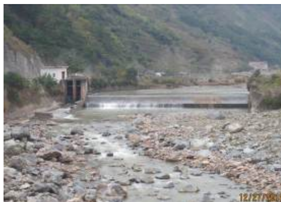
老木河电站闸坝
