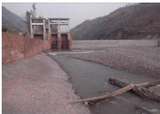
松新电站闸坝
