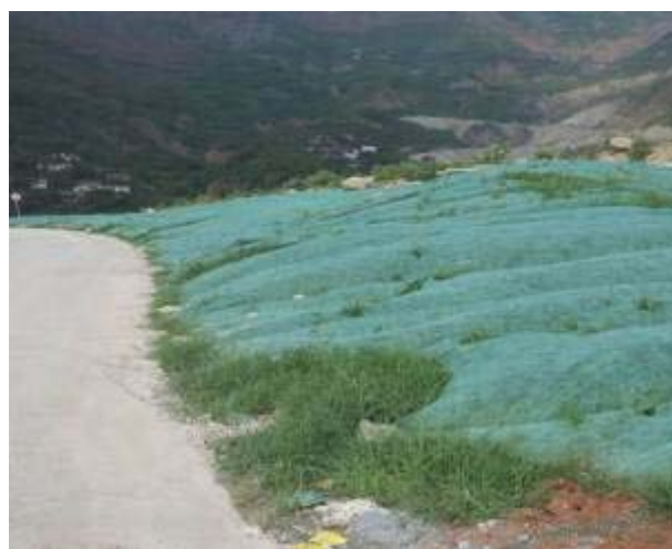
海子尾巴施工道路生态修复
