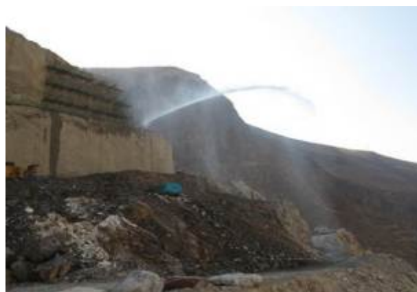
高压喷枪喷水
