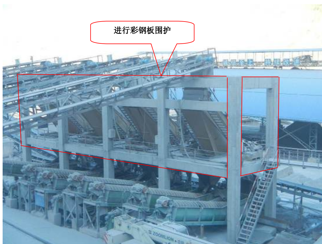
图 6.7-16 第三筛分车间彩钢板围护示意图
