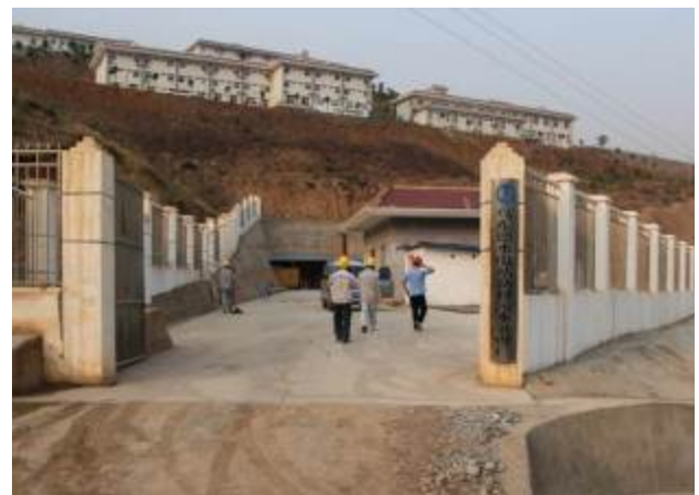
新村地埋式污水处理装置
