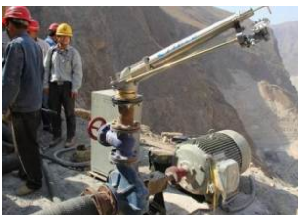
高压喷枪喷水
