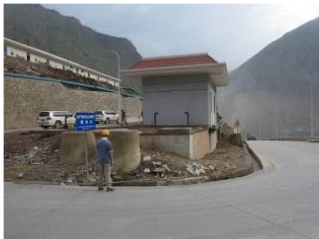
金坪子 2#地埋式污水处理站
