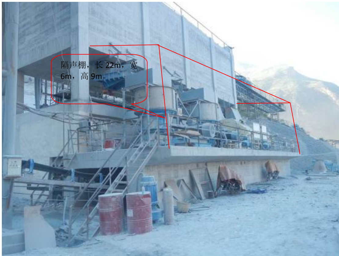
图 6.7-10 中细碎车间隔声防护棚示意图
