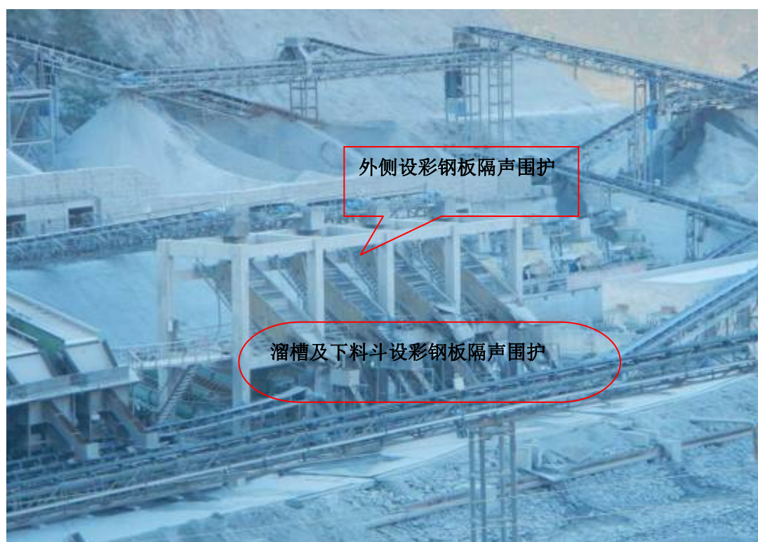
图 6.7-15 三筛车间隔声措施示意图
